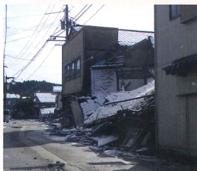
能登半島地震の被害状況
